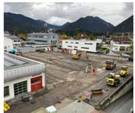
Durch die neue Bebauung entstehen 91 Stellplätze. Die Fahrbahn wurde asphaltiert, die Stellplätze gepflastert, somit soll es in Zukunft keine so starke Staubentwicklung mehr geben. Die Versickerung erfolgt über aktive Bodenpassagen in welchen stirnseitig im Frühjahr Bäume gepflanzt werden. Die Arbeiten wurden termingerecht ausgeführt, Bauzeit ca. 7 Wochen.
